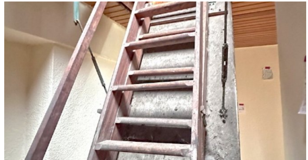
DG Zugang Spitzboden
