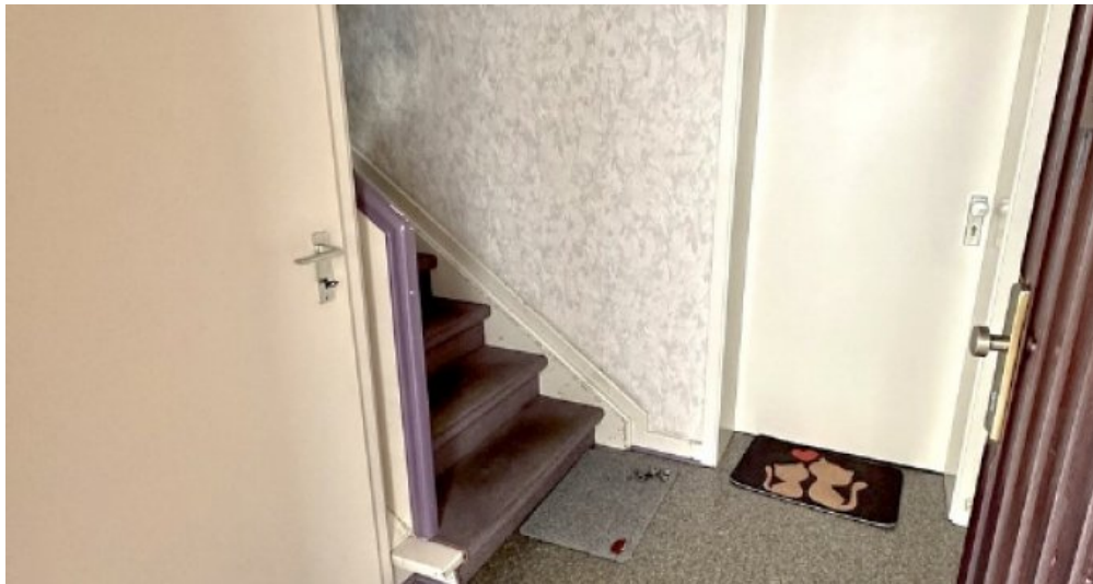
EG Eingang Treppenhaus
