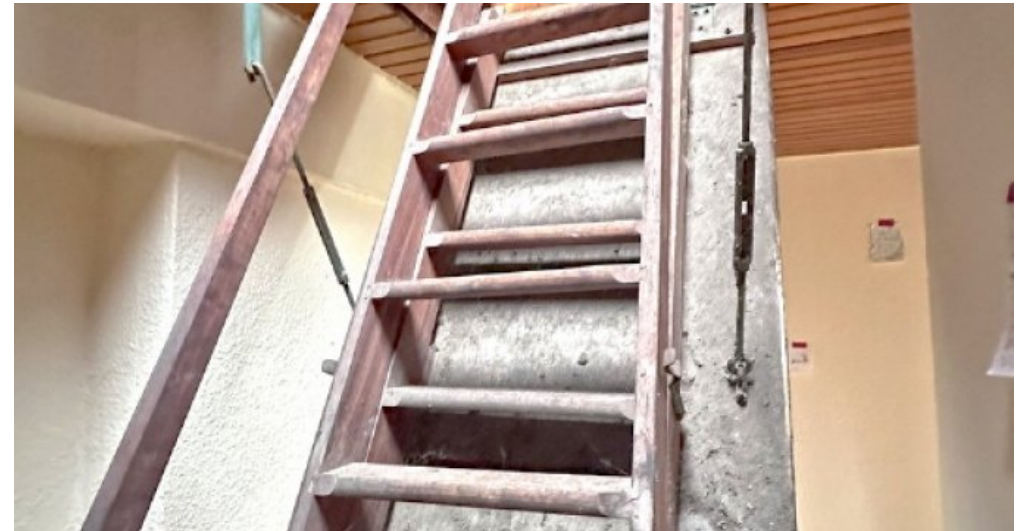
DG Zugang Spitzboden
